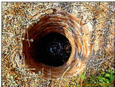
บ่อพักน้ำก่อนเข้าระบบบำบัดน้ำเสียของอาคารผู้โดยสารขาเข้า ชุดที่ 1
