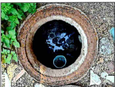
บ่อฟักน้ำหลังผ่านระบบบำบัดน้ำเสียของอาคารหอบังคับการบิน
