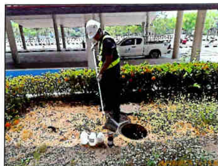
บ่อฟักน้ำก่อนเข้าระบบบำบัดน้ำเสียของอาคารผู้โดยสารขาออก ชุดที่ 3
