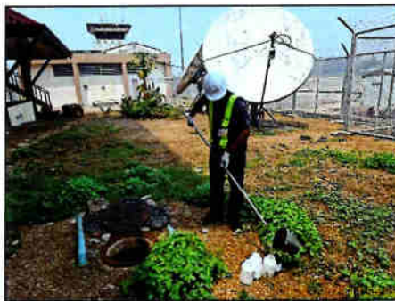
บ่อฟักน้ำหลังผ่านระบบบำบัดน้ำเสียของอาคารหอบังคับการบิน
