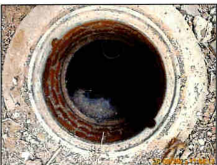
บ่อพักน้ำหลังผ่านระบบบำบัดน้ำเสียของอาคารผู้โดยสารขาออก ชุดที่ 2
