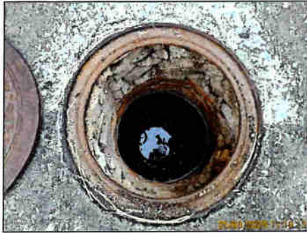
บ่อพักน้ำก่อนเข้าระบบบำบัดน้ำเสียของอาคารผู้โดยสารขาออก ชุดที่ 1
