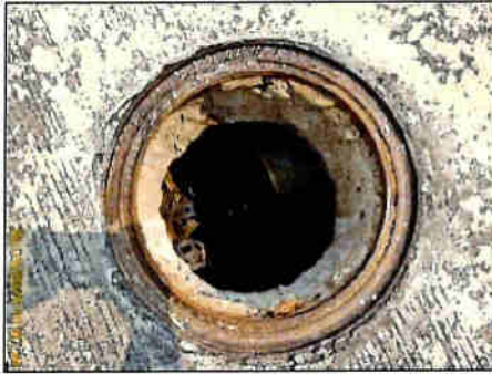
บ่อฟักน้ำก่อนเข้าระบบบำบัดน้ำเสียของอาคารผู้โดยสารขาเข้า ชุดที่ 3
