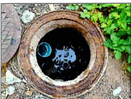
บ่อฟักน้ำก่อนเข้าระบบบำบัดน้ำเสียของอาคารหอบังคับการบิน
